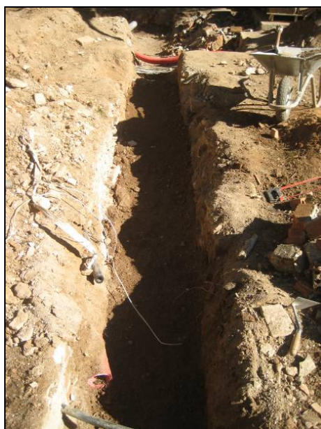
Rasa 9000 coberta d'una capa de terra per a protegir les restes
