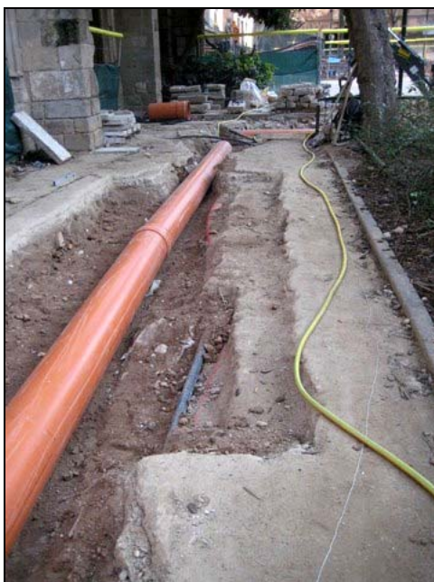
Rasa 1000 un cop col·locat el nou tub de PVC
