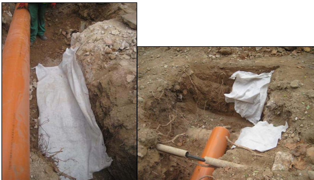
Protecció de les estructures amb geotèxtil
