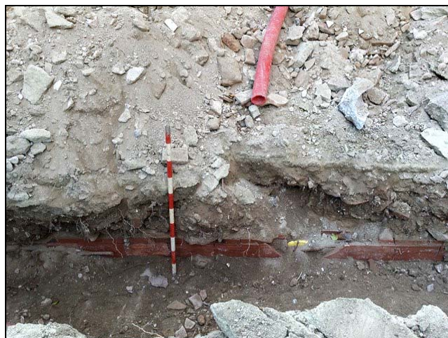
Vista del perfil SE de la rasa 7000 on es veu gran quantitat de runa amb un servei de gas
