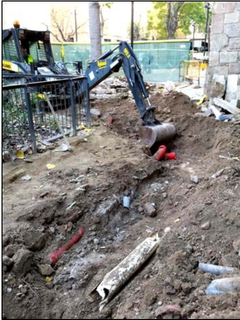
Imatge dels treballs de rebaix de la rasa 7000
