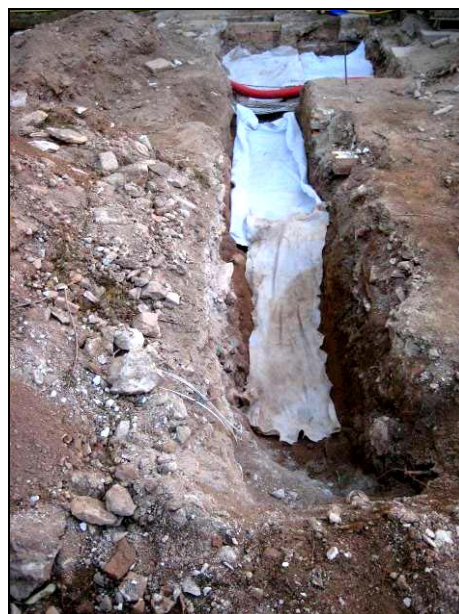
Rasa 9000 amb geotèxtil
