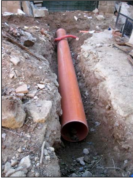
Rasa 7000 amb el tub de PVC
