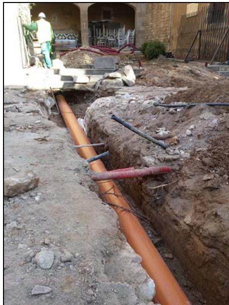
Vista de la rasa 4000 amb el nou tub de PVC
