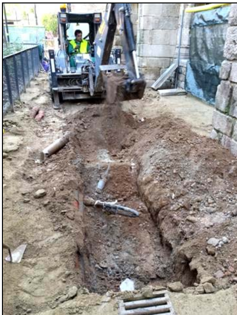
Inici dels treballs de rebaix de la rasa 6000
