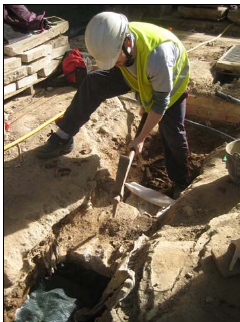
Imatge del desmuntatge de la fonamentació UE 1003
