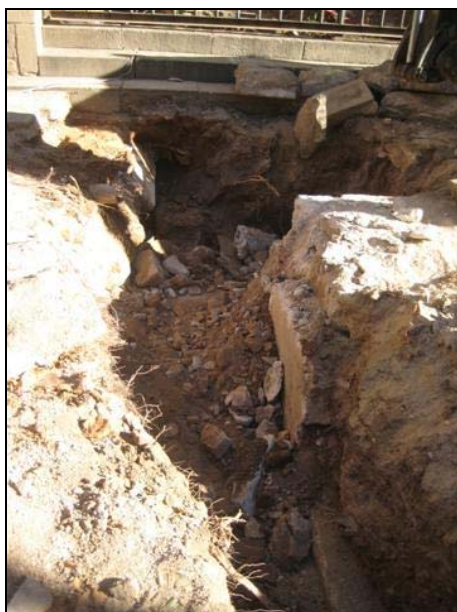
Rasa 5000 un cop eliminades les estructures
