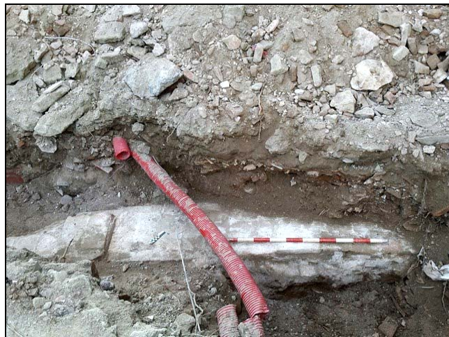
Vista NW de la UE 7003
