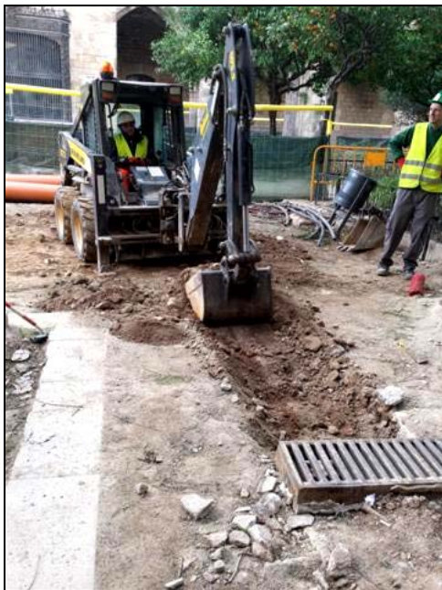
Inici dels treballs de rebaix de la rasa 9000
