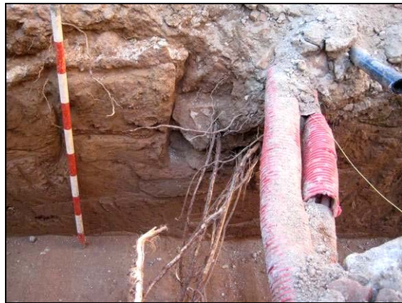
Imatge del servei UE 5021 com afecta la UE 5003 i la UE 50022.
