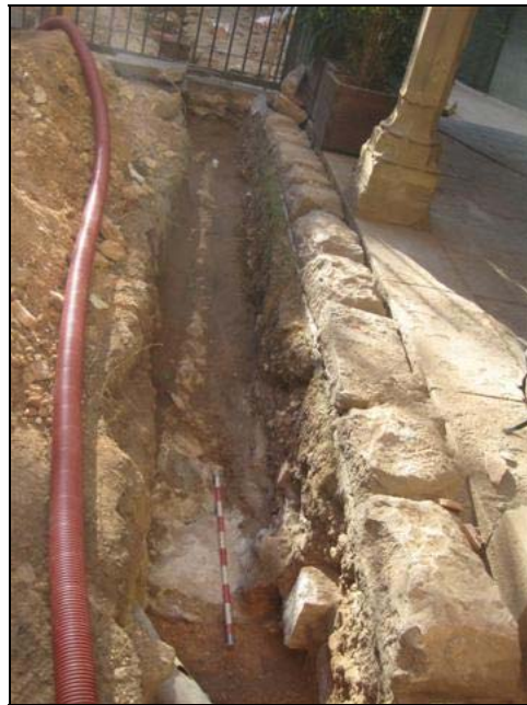
Vista final de la rasa 4000 un cop finalitzat el desmuntatge de les estructures
