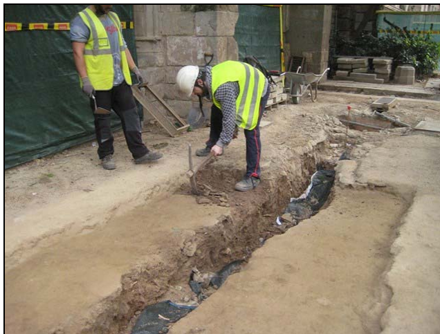
Treballs d'eixamplament de la rasa 1000
