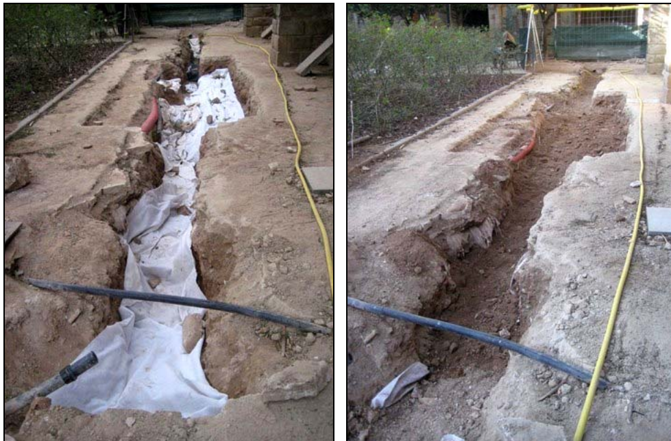
Rasa 1000 amb les restes cobertes amb geotèxtil
