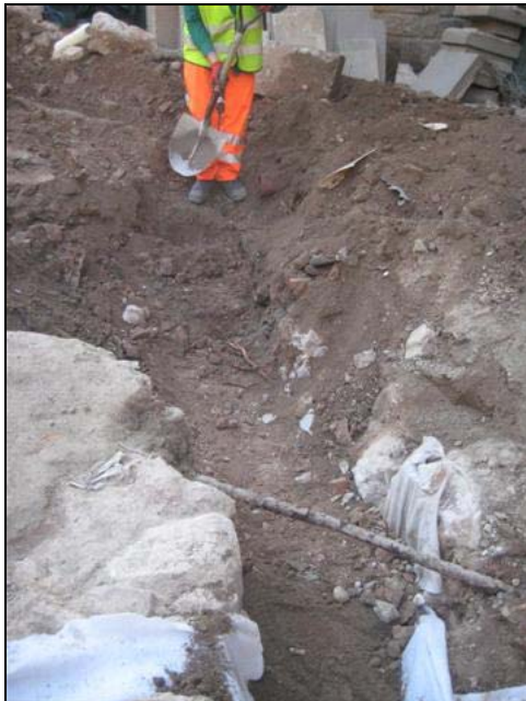
Treballs d'unió de la rasa 6000 i 7000
