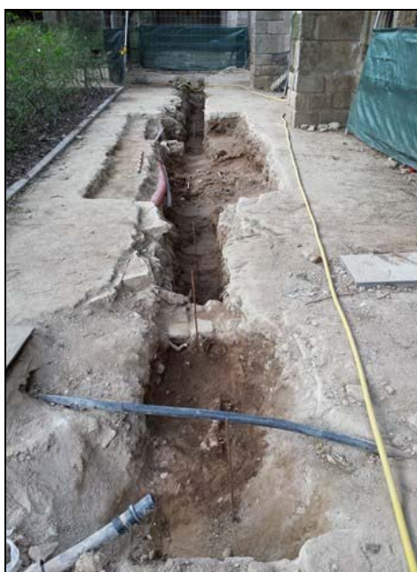
Vista al NW de la rasa 1000 un cop finalitzada
