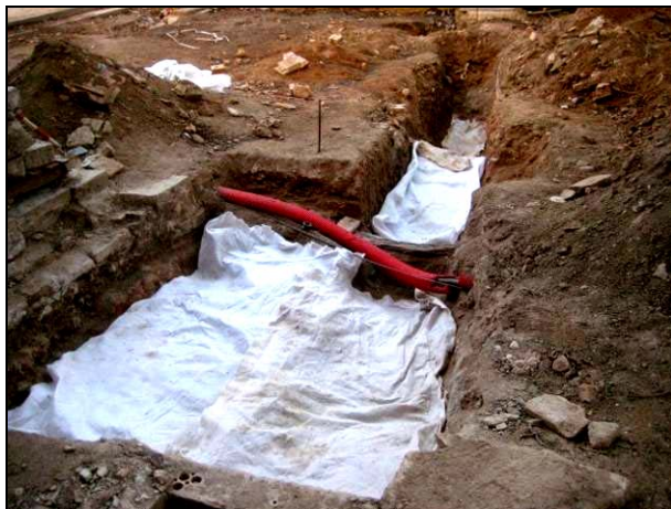
Rasa 9000 amb geotèxtil
