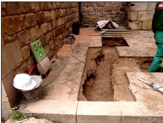
Imatge de l'obertura
