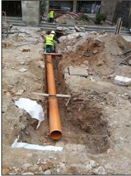
Rasa 5000 amb el tub de PVC
